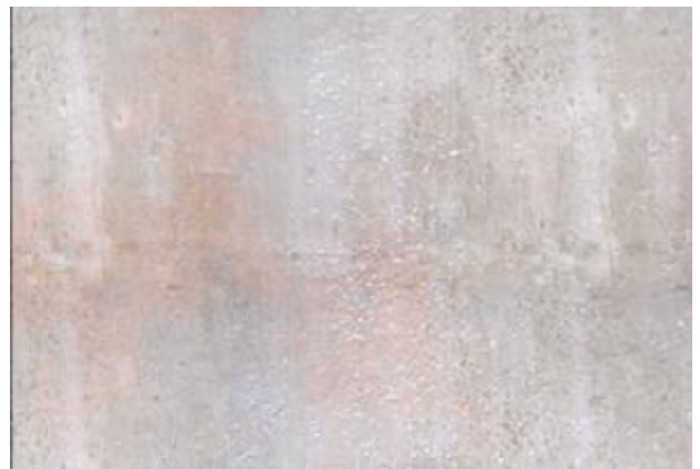
Hormigón con manchas de óxido
